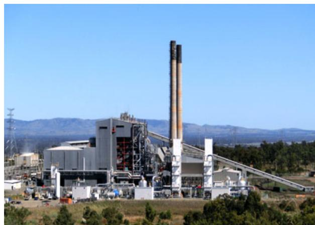
ここで採用されているのが酸素燃焼方式という、純粋な酸素で石炭を燃やして発電する方法です。通常の火力発電所では空気を使って石炭を燃やします。酸素で燃焼を行うと排気ガスの95%が二酸化炭素濃度となって、効率よく二酸化炭素を回収できます。回収した二酸化炭素は地下に貯留され
